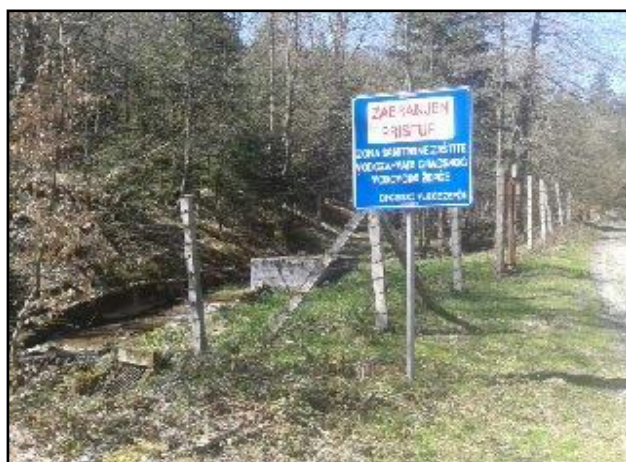
Slika 17. Objekat vodozahvata “Ravna rijeka“
