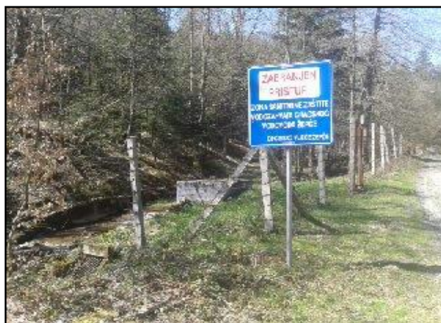
Slika 17. Objekat vodozahvata “Ravna rijeka“
